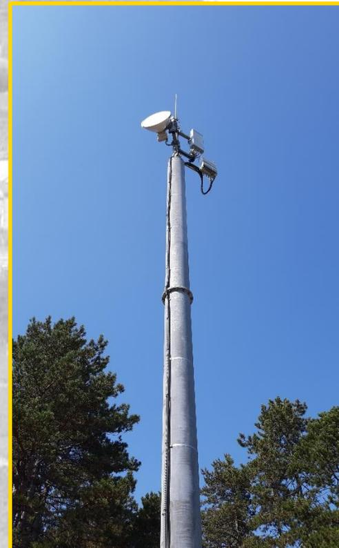
**Particularité :** Nécessité de remplacement de la collecte hertzienne. Pose de 3 liaisons hertziennes haut débit entre Leynes, St-Amour-Bellevue et Macon en un temps restreint pour minimiser la coupure de services aux abonnés.
